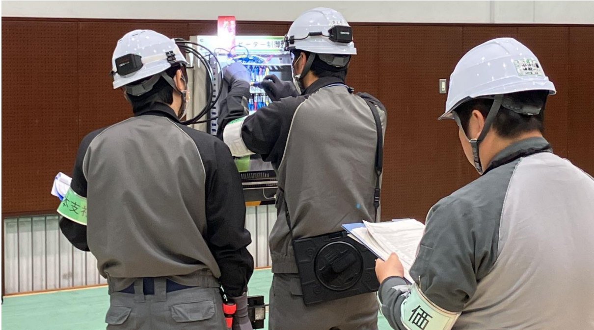
競技大会の風景（ヒーター制御盤での作業）
